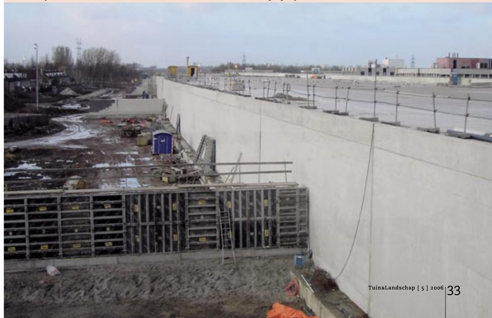
De betonnen muur met kussenvormig patroon wordt in de toekomst geel geleverd.
