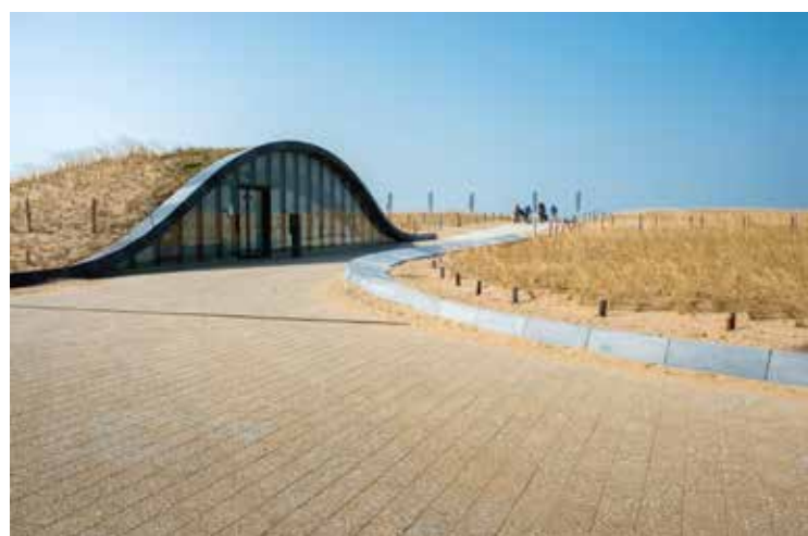
Bij de entrees van de parkeergarage voor voetgangers wordt het duinlandschap als het ware opgetild. Glazen gevels markeren deze entrees en zorgen tegelijk voor daglicht in de garage.
